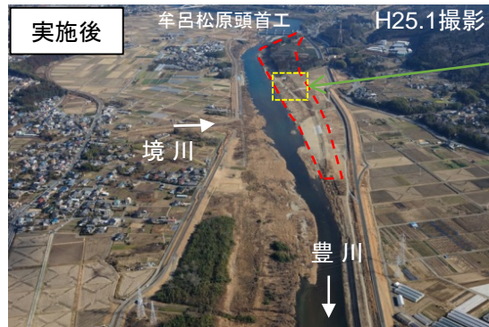
河道掘削状況 (H26年度完成)
