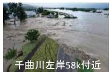
千曲川左岸58k付近
