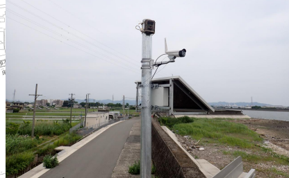
タイムラプスカメラ設置状況
