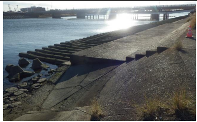
根固めブロック
