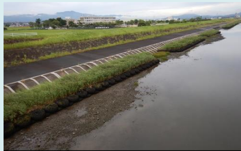
平成27年度施工箇所(放水路)
