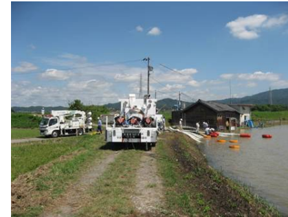
広田川の堤防決壊現場での 排水作業（愛知県幸田町）
