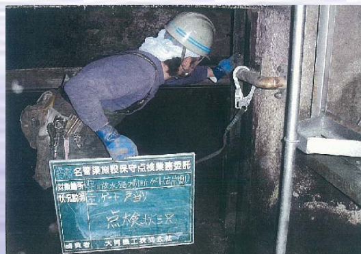
許可工作物出水期前点検実施状況
