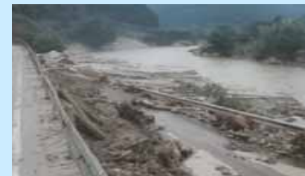
(H12年9月矢作ダム土砂流入状況)
