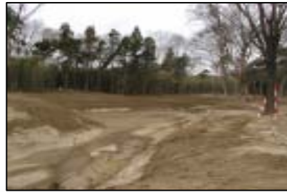
掘削直後の状況 H15.3
