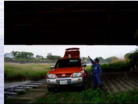
テロ対策巡視(国1橋梁)
