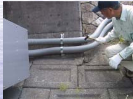
許可工作物出水期前点検実施状況
