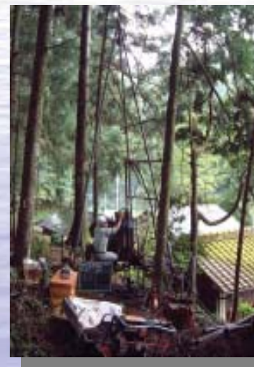
付替道路 ボーリング調査
