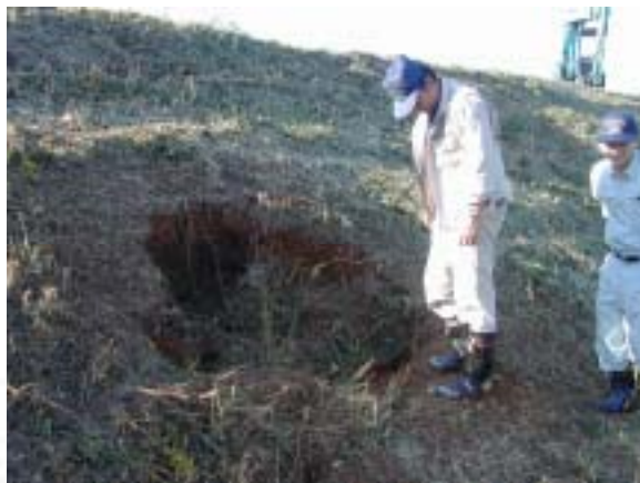
小動物によると思われる堤防陥没状況及び同修繕実施後状況
