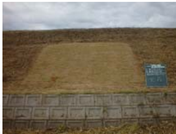
小動物によると思われる堤防陥没状況及び同修繕実施後状況
