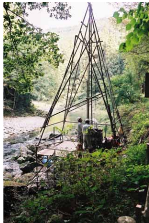
ダムサイト地質調査
