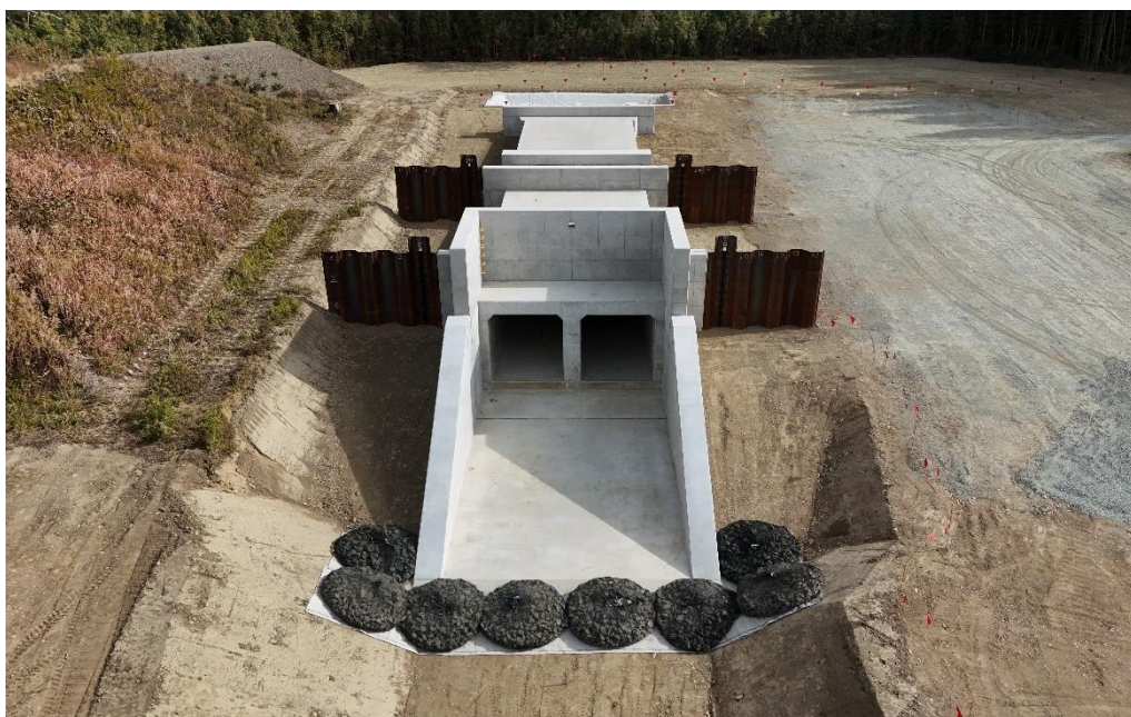
図 3.28 賀茂樋管の概成（令和6年12月撮影）
