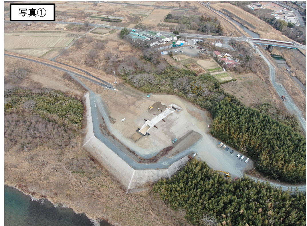
工事状況(R8.1)
