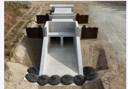
▲賀茂樋管の概成(令和6年12月撮影)
