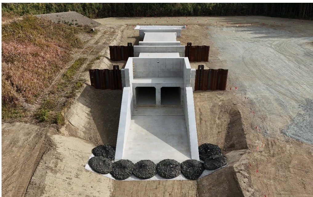
図 3.28 賀茂樋管の概成（令和6年12月撮影）
