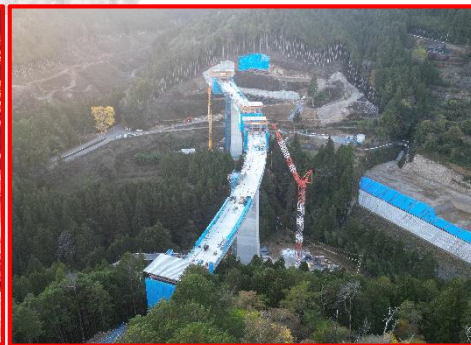
④4号橋PC上部工
