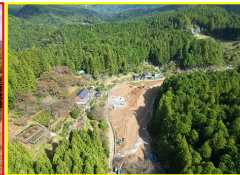
②小松地区道路建設
