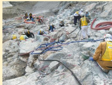
岩盤清掃(河床部)
