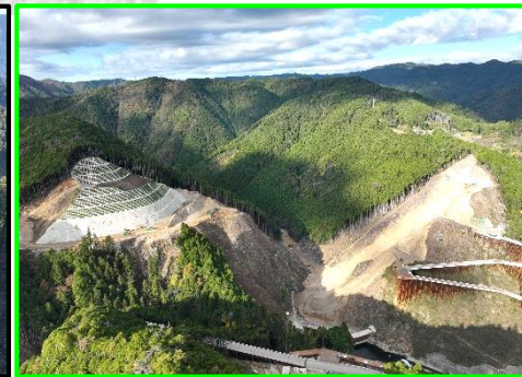
①本体建設第1期(上流側より)
