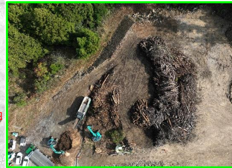
④添沢地区整備(大畑工区)
