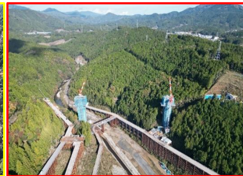
⑥5号橋PC上部工
