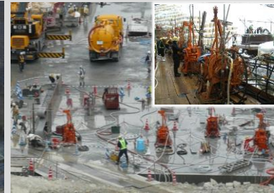
基礎処理工(グラウチング)
