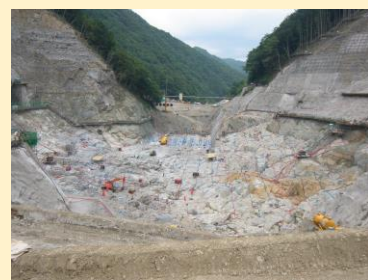
掘削完了時の全景
