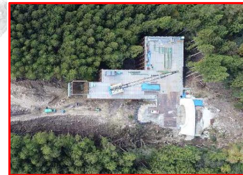
②R5・3号橋下部工
