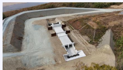
▲完成した賀茂樋管(令和6年12月撮影)
