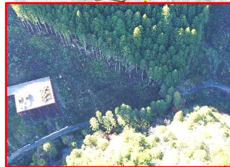
③R6・3号橋下部工
