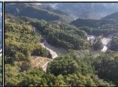
5号トンネルから国道257号
