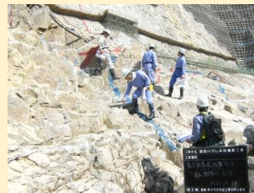
岩盤検査の様子
