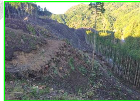
③貯水池東部整備(田口工区)
