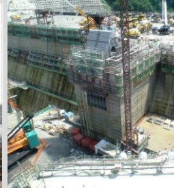
選択取水設備設置
