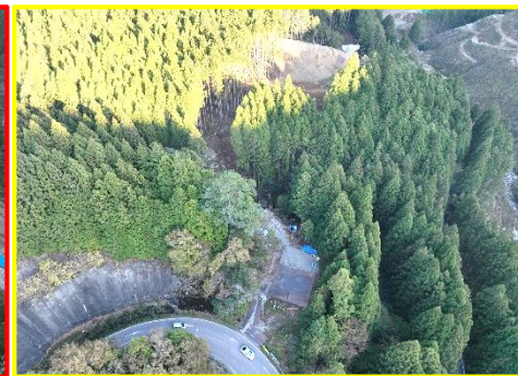
⑤川向地区道路建設
