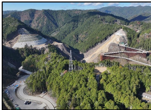
② 上流側より
