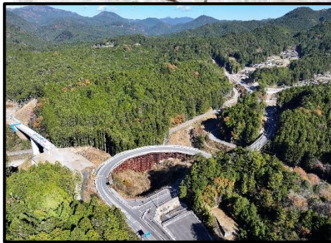
設楽根羽線起点から1号トンネル
