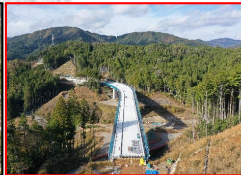
①2号橋床版工
