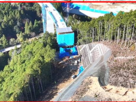
③4号橋下部工A1橋台
