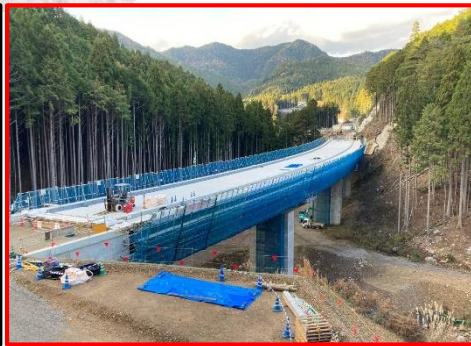
①3号橋床版工
