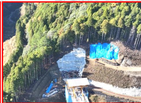
③4号橋下部工A2橋台
