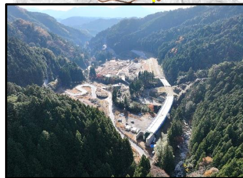
瀬戸設楽線1号橋から1号トンネル
