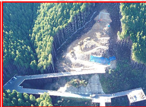
④松戸地区橋梁下部工
