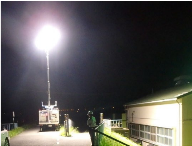
【照明車による夜間照明作業】
