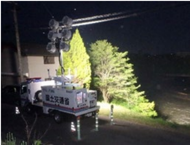
【照明車による夜間照明作業】
