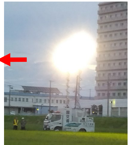
【照明車による夜間照明作業】
