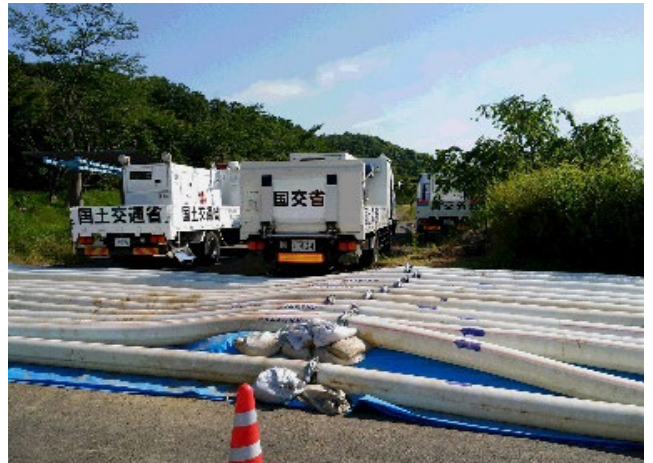
【ポンプ車による取水作業】
