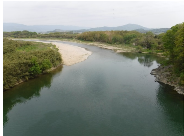
河川状況(4/23 三上橋上流)
