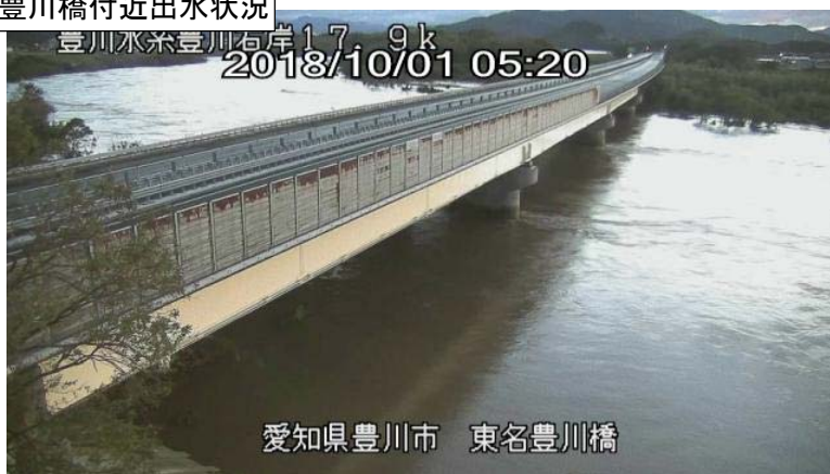
東名豊川橋付近出水状況
