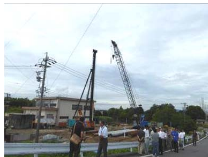
家下川新排水機場の工事現地視察
