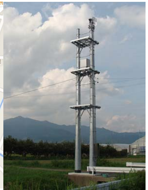
設置されたカメラ
