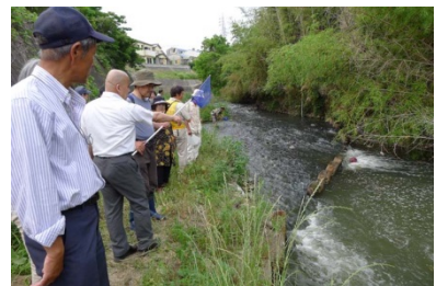
家下川合流点段差改善箇所の確認
