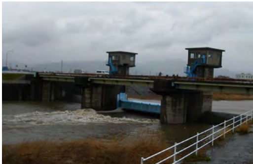
豊川放水路分流堰
