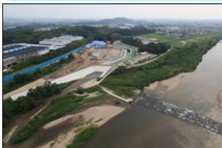
H26.7時点（分派施設本体内基礎地盤整正）
