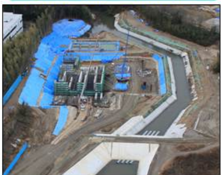
H27.1時点（鉄筋組立）
