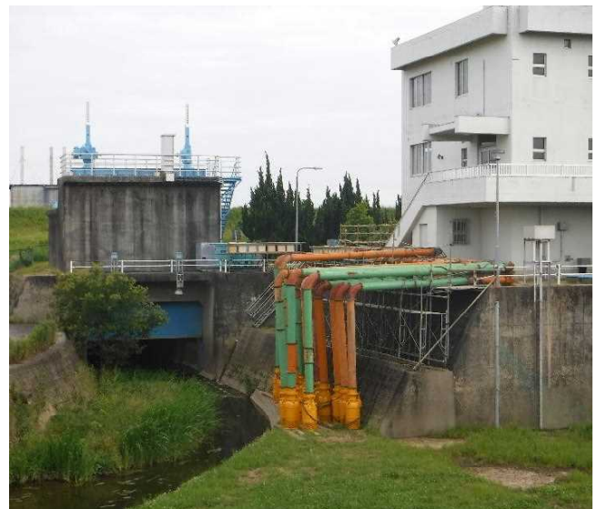
↑ 設置が完了した仮設排水施設
