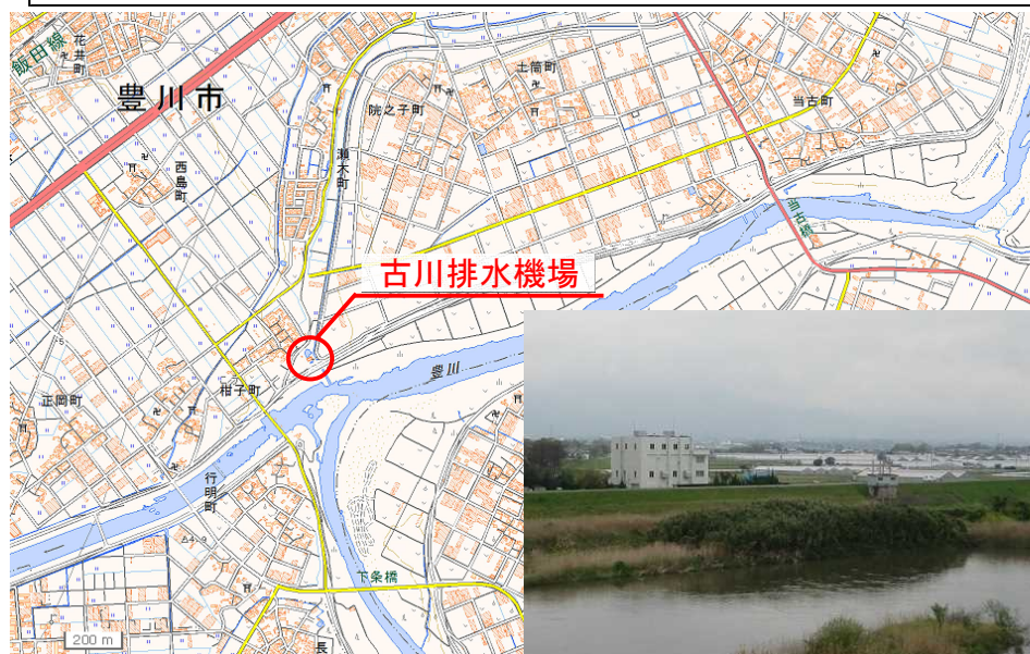
古川排水機場の設置場所と施設外観
