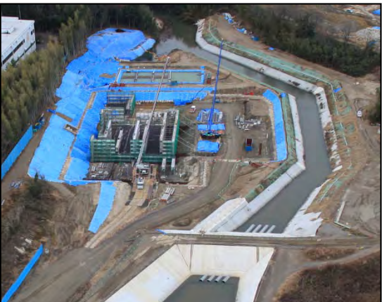
H27.1時点（鉄筋組立）
