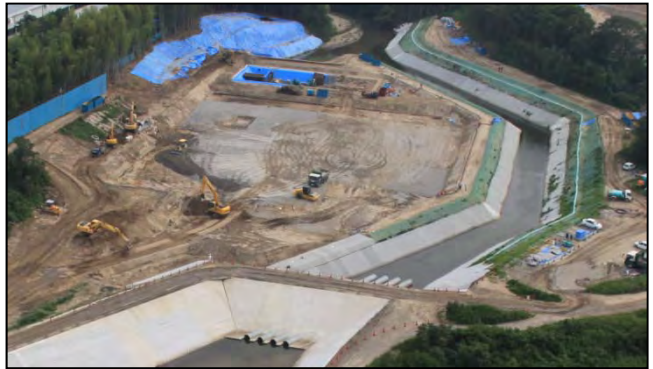
H26.7時点（分派施設本体内基礎地盤整正）
