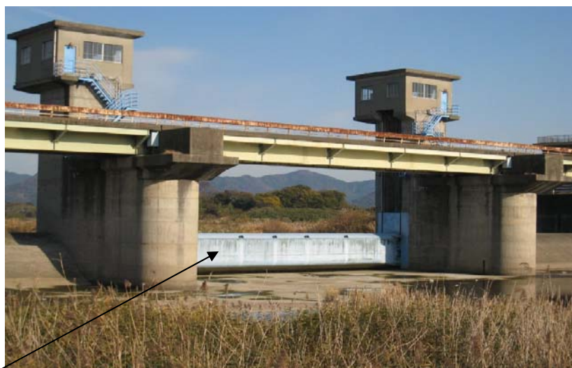
放水路分流堰(下流側から望む)
