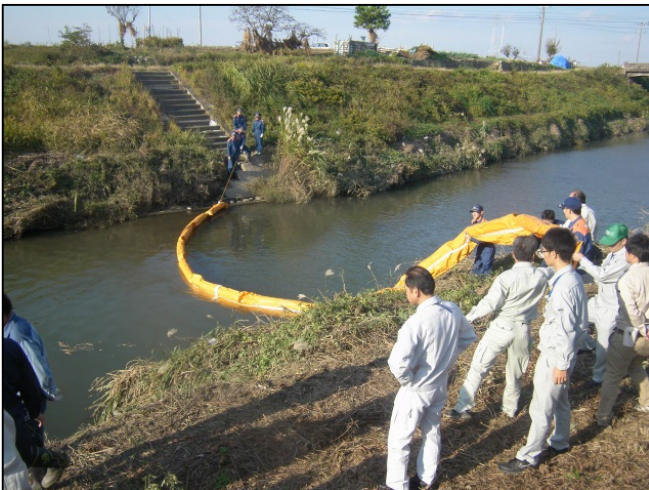
オイルフェンスの設置
