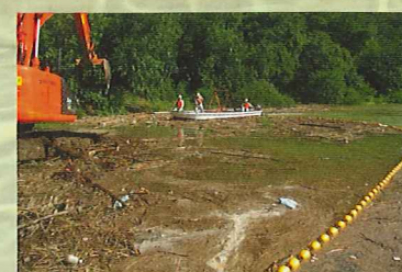
ダム貯水池の流木処理
