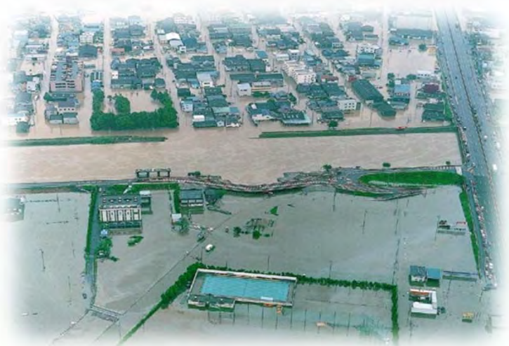
東海豪雨 平成12年9月：庄内川・新川
