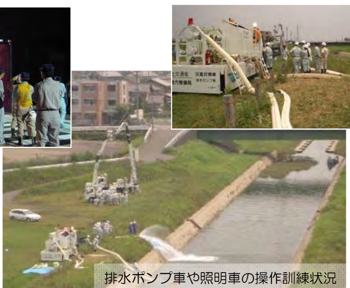
長良陸閘（長良川）全閉後の水密確認
