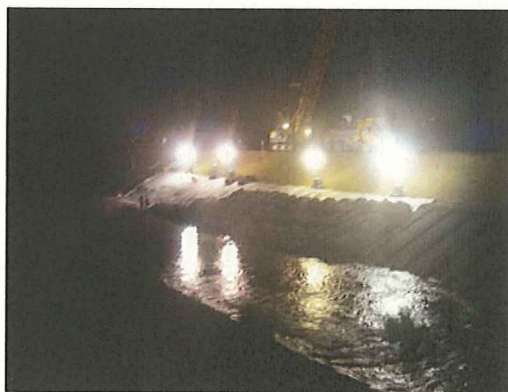
(豊川支川間川での応急復旧)
