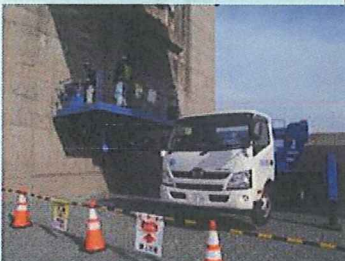
■耐震補強作業
