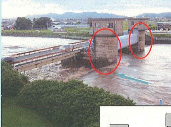
■耐震補強箇所 （平成23年9月洪水時）
