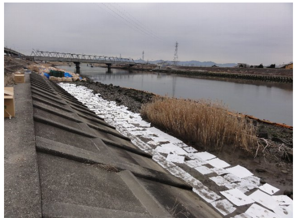
現場対策状況(オイルマットによる吸着)
