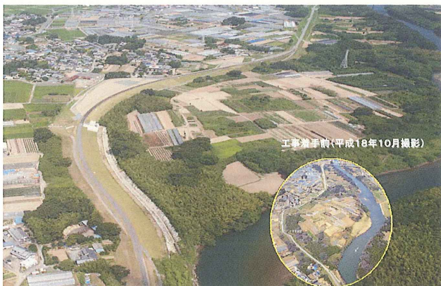
(平成23年7月に竣工した豊川大村地区の堤防整備)
