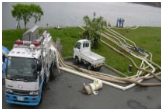
排水ポンプ・ホース等設置完了
