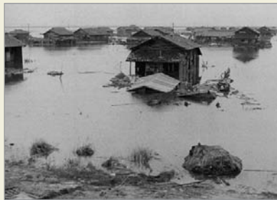
S34洪水/碧南市の被災状況
