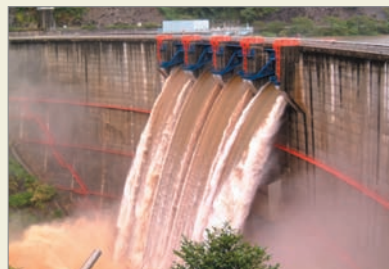
H12洪水/矢作ダム出水状況
