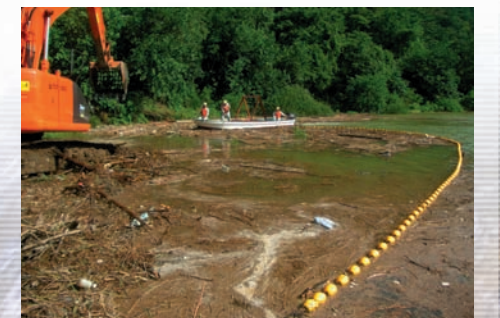
ダム貯水池の流木処理
