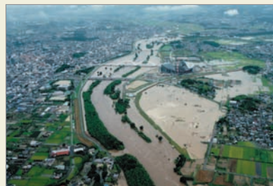
H12洪水/豊田市の越水状況
