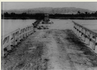
S34洪水/岡崎市美矢井橋の被災状況
