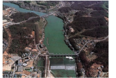
明治用水頭首工
