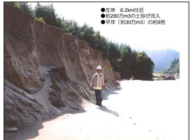
H12恵南豪雨時に矢作ダム貯水池に堆積した土砂
