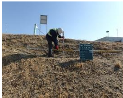
堤防点検の実施状況
