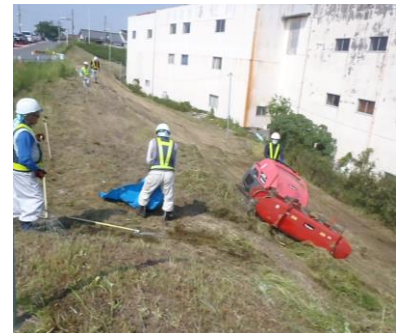
除草作業状況
