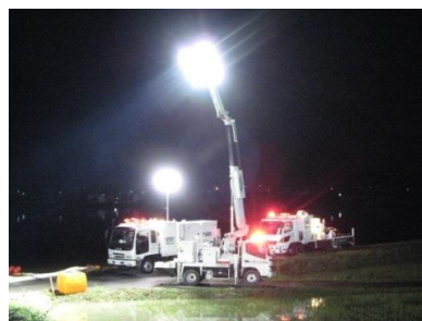
洪水時における支援状況 (排水ポンプ車による排水活動 幸田町 広田川 平成20年8月)
