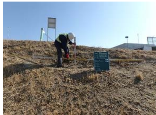
堤防点検の実施状況
