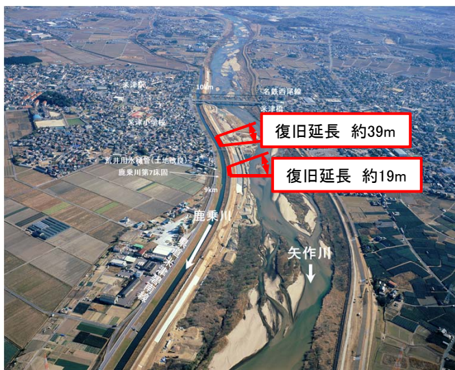
鹿乗川左岸(西尾市米津地区)
