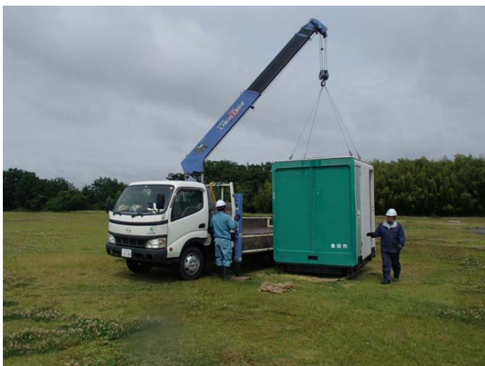
河川内公園の仮設トイレ搬出訓練
