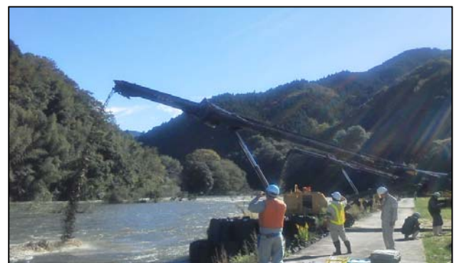
ベルトコンベアーを用いた給砂実験(平成29年10月)
