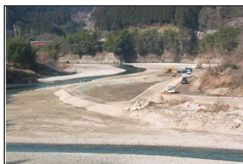
矢作ダム堆積土砂掘削状況
