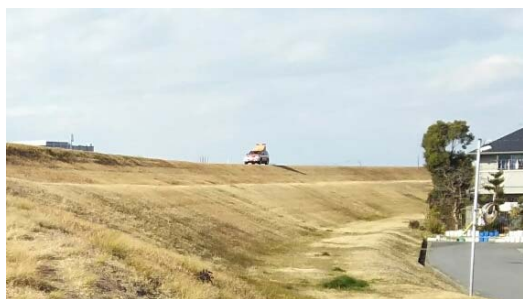
パトロール車による日常の巡視
