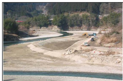
矢作ダム堆積土砂掘削状況
