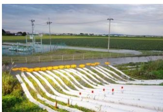
関東・東北豪雨での支援状況 (排水ポンプ車による排水活動 大崎市 H27.9)
