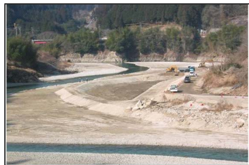
矢作ダム堆積土砂掘削状況
