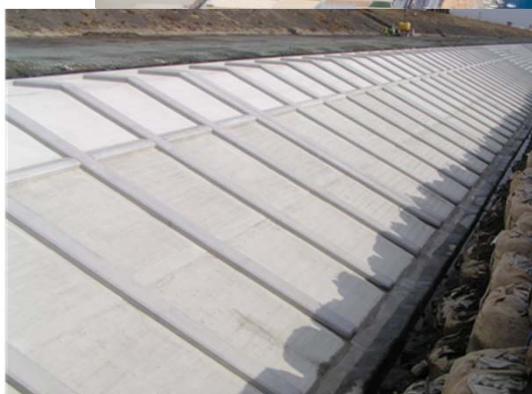
■再度被災防止護岸施工例
