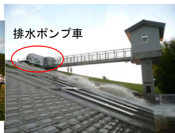
洪水時における支援状況 (排水ポンプ車による排水活動 豊橋市 平成23年7月)
