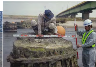
■旧下部工の状況
