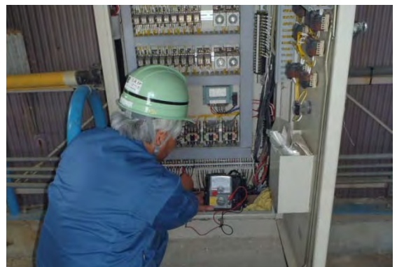
■機械設備の点検状況
