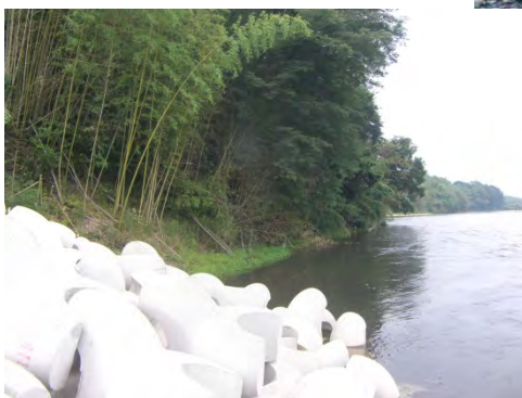
■再度被災防止護岸施工 (豊田市渡合地区)
