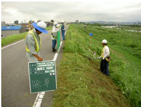
■堤防除草作業状況
