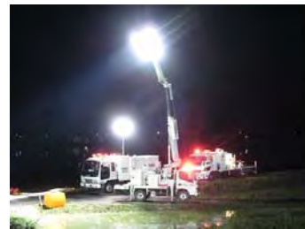
■洪水時における支援状況 (排水ポンプ車・照明車による排水作業 愛知県幸田町 広田川 平成20年8月)
