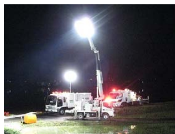
■洪水時における支援状況 (排水ポンプ車・照明車による排水作業 愛知県幸田町 広田川 平成20年8月)
