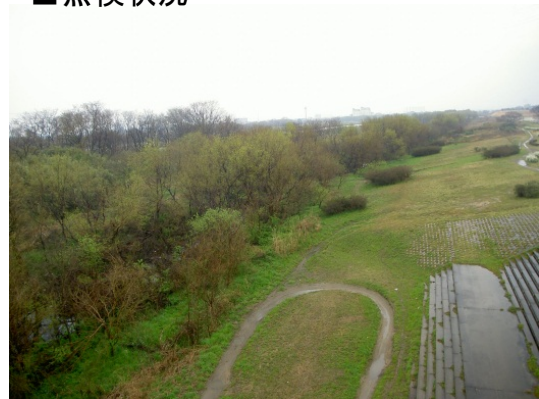
■ 洪水時の流れを阻害する 河道内樹林の繁茂状況
