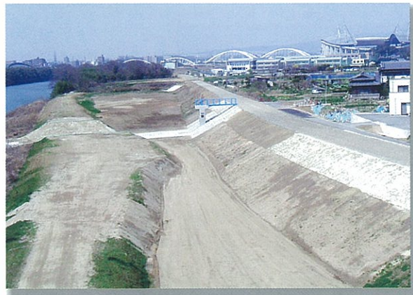
野見築堤護岸樋管工事(豊田市)
