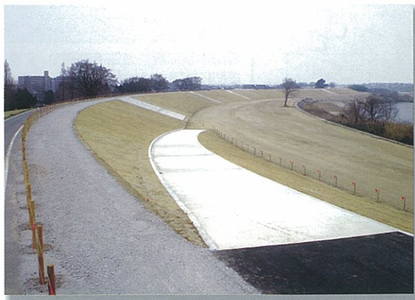
上里大門築堤護岸工事(岡崎市)
