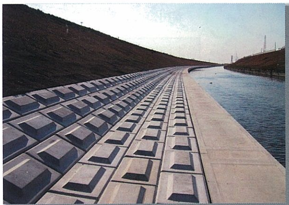
米津護岸災害復旧工事 平成16年度完成 (右岸8.6km地点)
