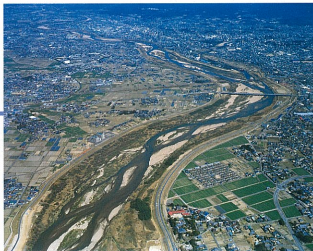
19.0km地点より上流を望む
