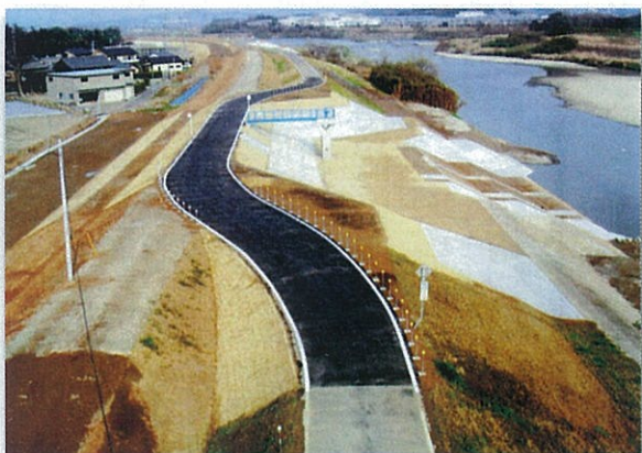
大畑樋管工事 平成15年度完成(11.9km地点)
