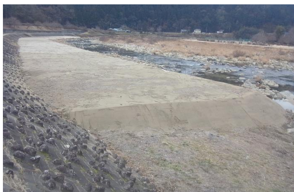
土砂供給実験(置土)の実施状況(令和4年12月)
