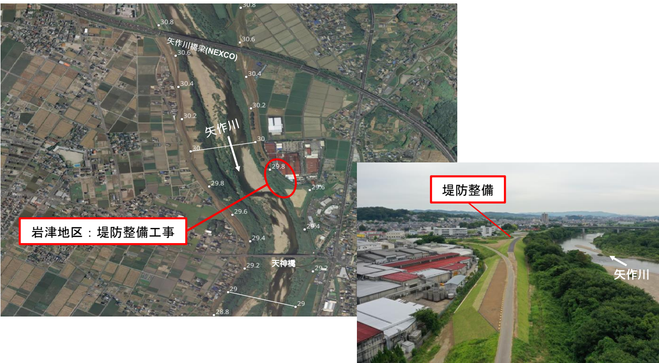
岩津地区施工状況（R6年度）
