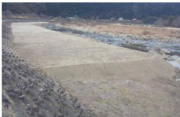
土砂供給実験(置土)の実施状況(R4年12月)
