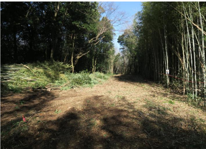
施工状況：近景 (R5年度)
