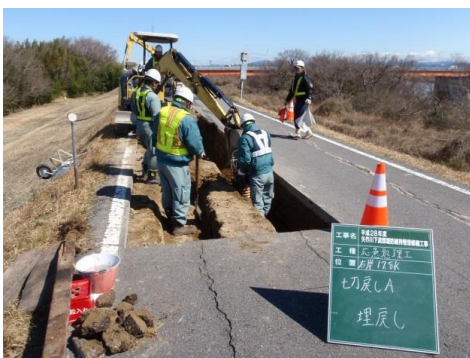
堤防の補修作業の状況
