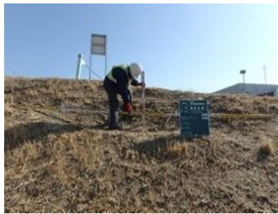
堤防点検の実施状況
