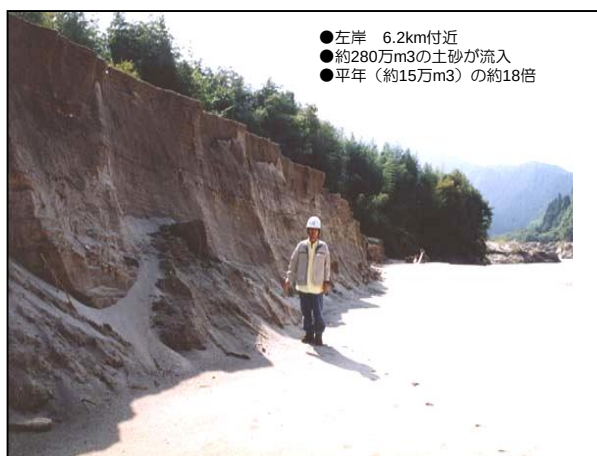
H12年恵南豪雨時に矢作ダム貯水池に堆積した土砂
