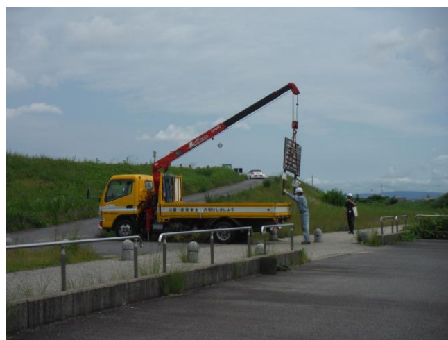
河川内公園の案内板撤去搬出訓練
