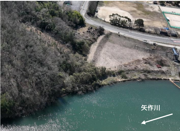
施工状況：遠景 (R5年度)
