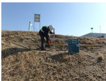
堤防点検の実施状況
