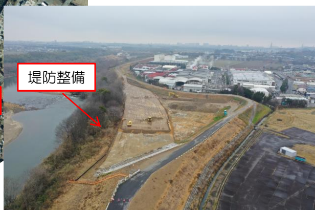
岩津地区施工状況 (R5年度)
