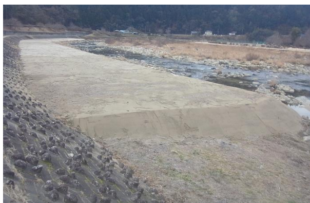
土砂供給実験(置土)の実施状況(令和4年1月)
