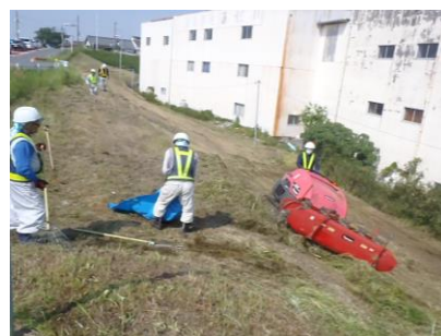
除草作業状況
