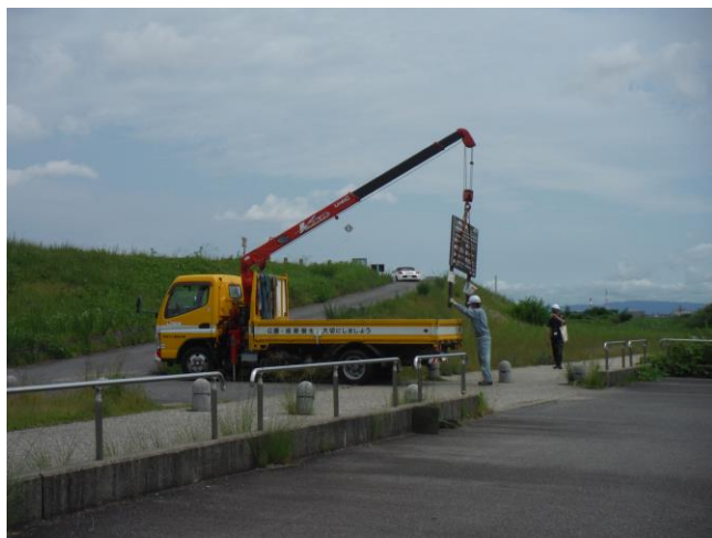
河川内公園の案内板撤去搬出訓練
