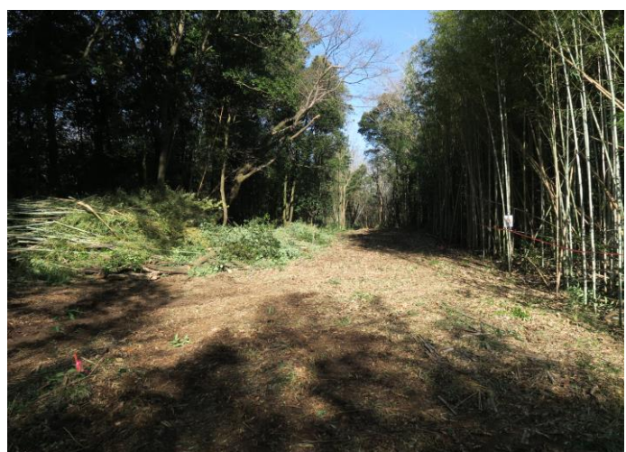
施工状況：近景 (R5年度)
