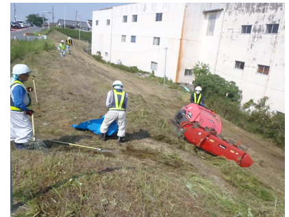
除草作業状況
