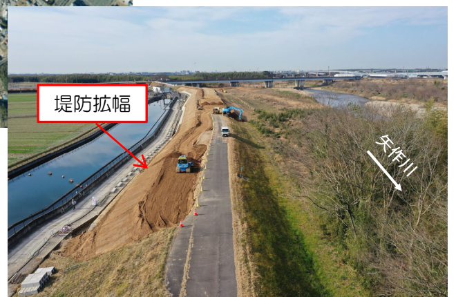
施工状況(R4年度)
