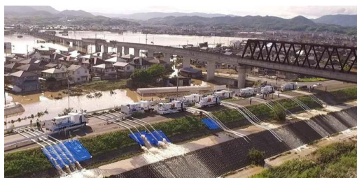
平成30年7月豪雨 被災地支援 (岡山県倉敷市真備町 平成30年7月)
