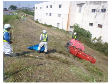
除草作業状況
