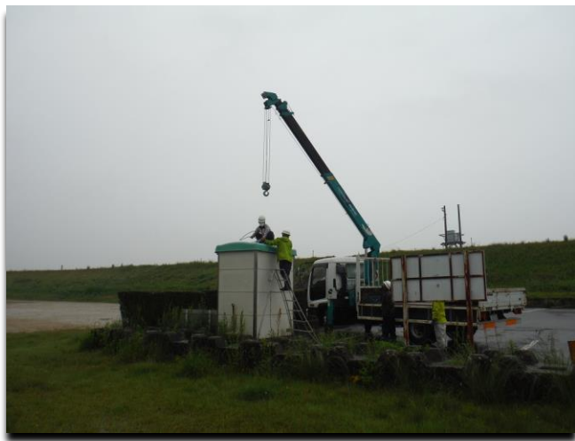
河川内公園の仮設トイレ撤去搬出訓練
