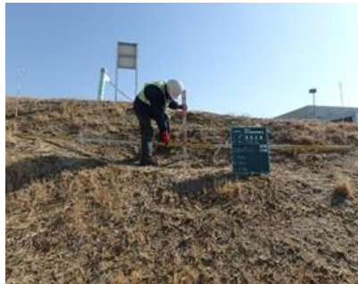
堤防点検の実施状況
