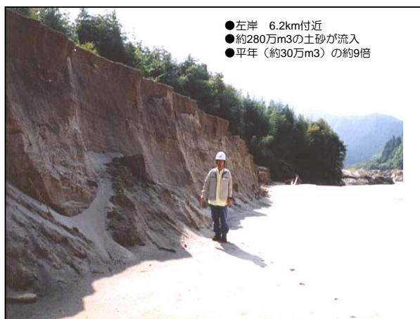
H12恵南豪雨時に矢作ダム貯水池に堆積した土砂
