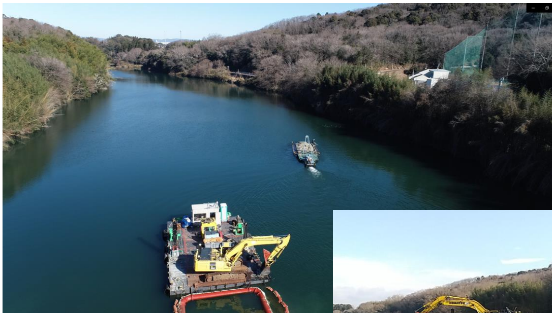
施工状況(R3年度)
